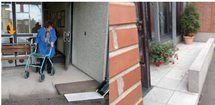
Kuva 13. Vasemmalla kuva Mäntsälän pilottikohteen Osuustien vanhustentalon sisäänkäynnistä ja oikealla kuva Helsingin pilottikohteen Loppukiri-talon B-rapun sisäänkäynnistä.
