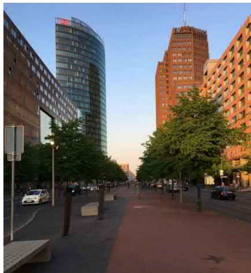
Kuva 40 ja 41 Yllä Daimler Chryslerin asunto- ja toimistokompleksi. Alla Potsdamer Strassen katuperspektiivi.
