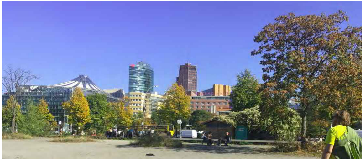
Kuva 56. Potsdamer platzin korkeat rakennukset erottuvat jo kaukaa
