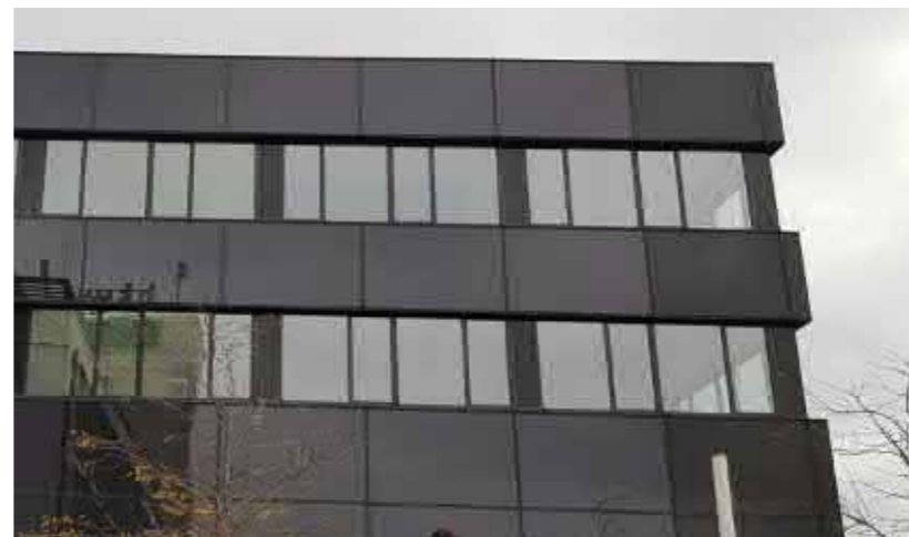
HTW:n kampuksen uudisrakennusosa
