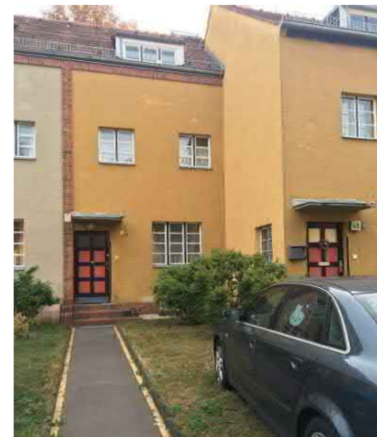
Kuva 12 ja 13 Yllä julkisivuote ja alla valokuva Liningstrassen asuintalosta.
