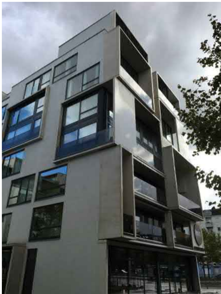
Kuva 22 Danziger Strasse 73:n julkisivua hallitsevat parveke-elementit.
