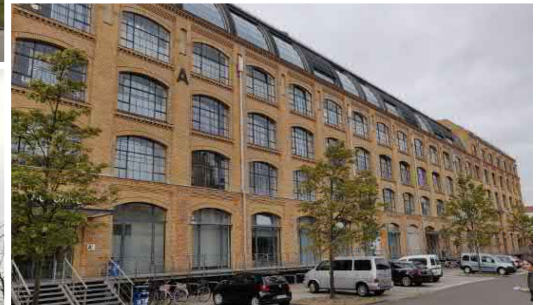
HTW:n kampuksen A-rakennus. Rakennus on vanha teollisuusrakennus.
